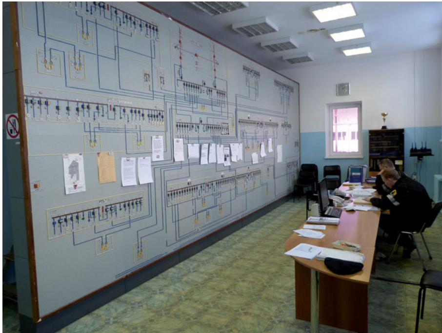
Рис. 2. Диспетчерский пункт электроцеха до внедрения СДУ
