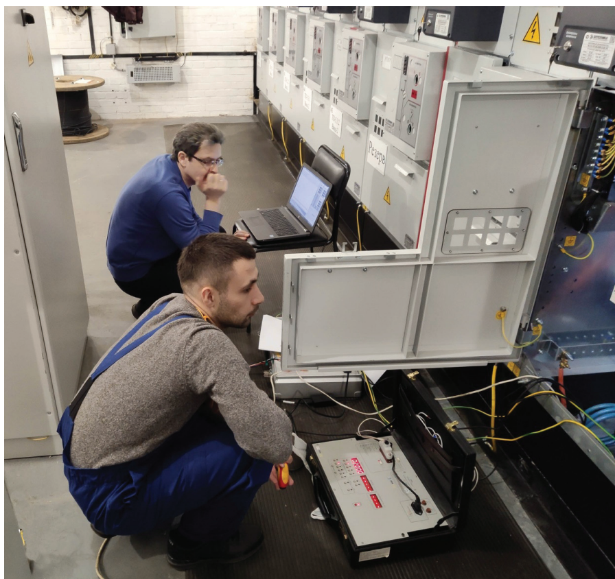
Рис. 4. Процесс калибровки устройства определения поврежденного фидера «НЕВА-ОПФ»
